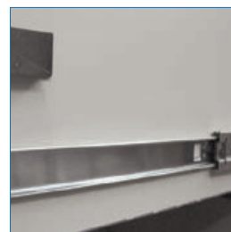
Riel deslizante lateral de cajones
